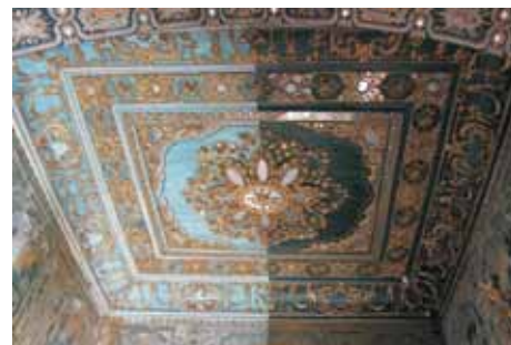
Decke des „Weintraubenzimmers“ im Nizam-Haus vor und nach der Abnahme der dunkelgrünen Übermalung, während des Restaurierungsprojekts durch den Aga Khan Trust for Culture und den Aga Khan Cultural Services Syria, 2011 (Foto: Anke Scharrahs)
