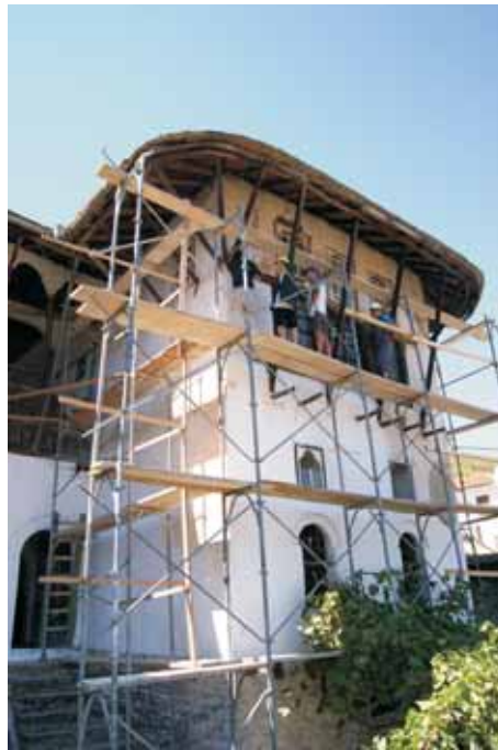
Skenduli-Turmhaus in Gjirokastra/Albanien: Inspektion der Mauer und seiner Bemalung (Foto: CHwB/AIP)
