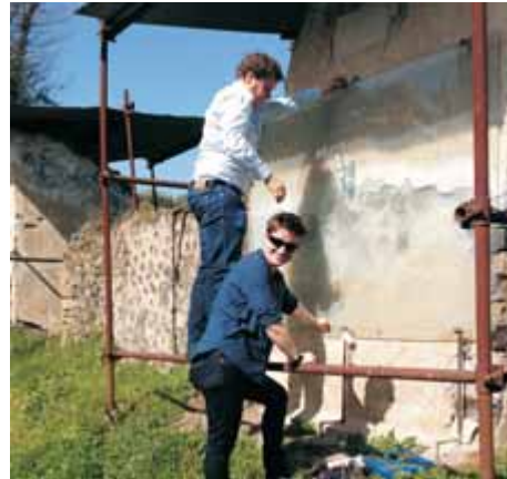
Wissenschaftler des Fraunhofer IBP bei Arbeiten an der Porta Nocera in Pompeji (Foto: Fraunhofer IBP)
