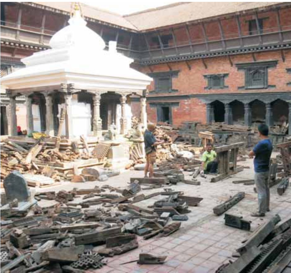
Harishankar-Tempel in Patan/Kathmandu-Tal: Sicherung der Einzelteile (Foto: Rohit Ranjitkar, 5. Mai 2015)
