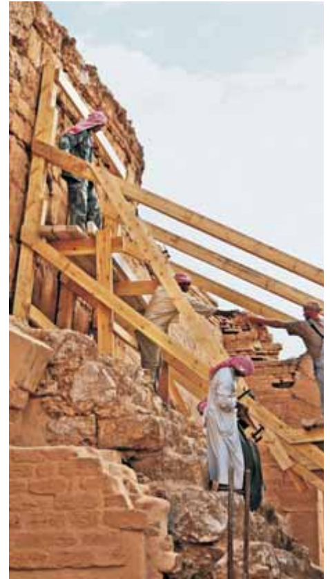
Temporäre Absicherung der Apsis der Basilika A in Resafa/Syrien (Foto: Martin Gussone, TU Berlin)
