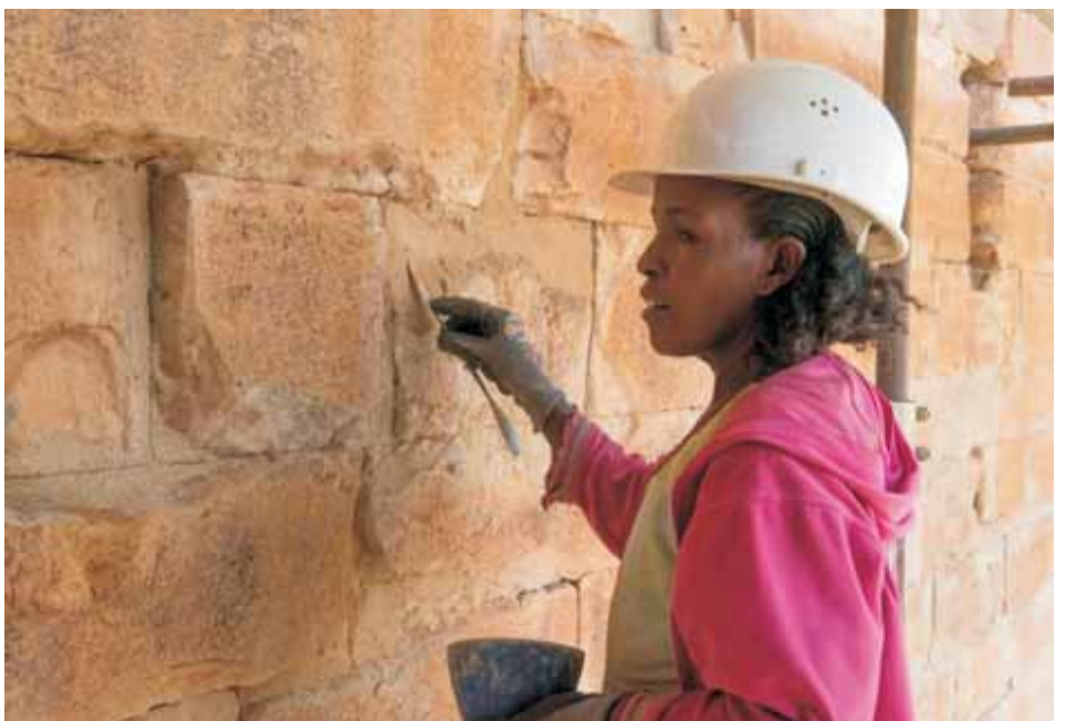
Restaurierungsarbeiten an den Rissbildern der Fassaden des Großen Tempels (Foto: I.Wagner/DAI, Orient-Abteilung)
