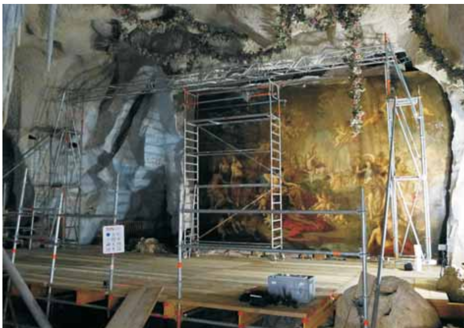
Ausbau des Monumentalgemäldes „Tannhäuser“ (1876/77) von August von Heckel aus der Venusgrotte in Linderhof (Foto: Inga Pelludat)
