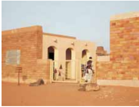
Der neu eröffnete Eingangsbau zu den königlichen Pyramidenfriedhöfen (Foto: DAI, A. Riedel)
