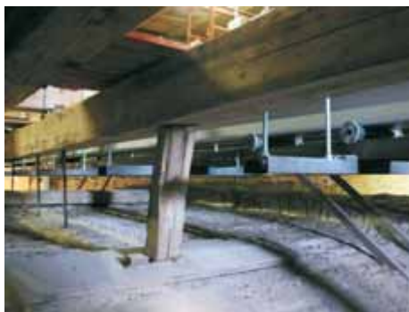
Die Träger werden auf Rollbahnen in den Dachstuhl geschoben (Foto: Bayerische Schlösserverwaltung)
