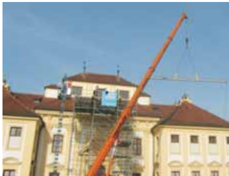
Ein Kran verankert Stahlträger im Gewölbe (Foto: Bayerische Schlösserverwaltung)
